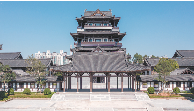
即将投入使用的广州文化馆非遗园。
